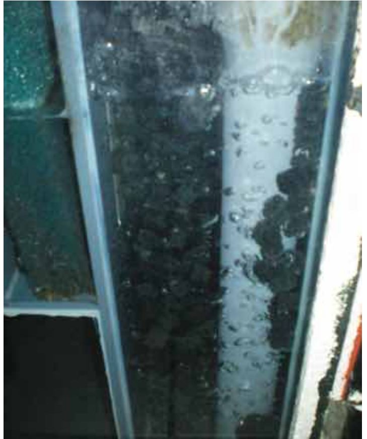
Der mit dem einlaufenden Wasser eingetragene Sauerstoff versorgt die nitrifizierenden Bakterien im Filter.
