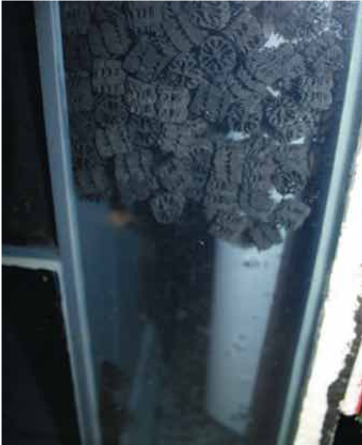
Die „Moving Beads“ (kleine Kunststoffkörper) als schwimmendes Vorfilterbett vor dem VA-Feinfiltersieb.
