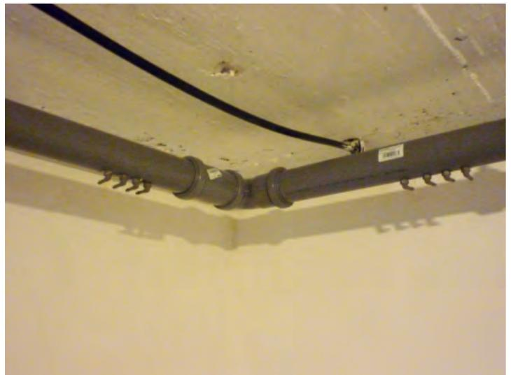
Die Ringleitung aus 50er HT-Rohr mit eingeschraubten Anschlusswinkeln (M 8x1, gebohrt 7 mm) wurde unter der Decke verlegt.
