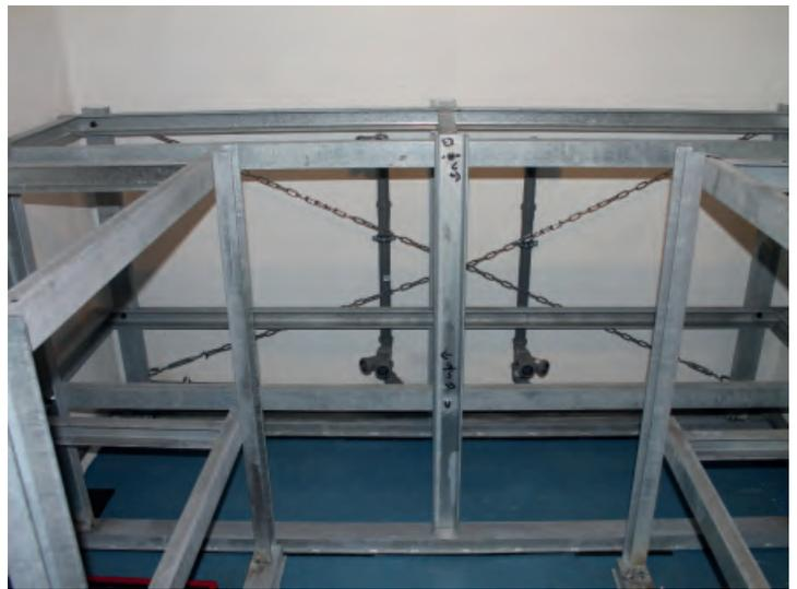
Eine stabile Unterkonstruktion aus U-Profil garantiert einen sicheren Stand. Die Aquarien stehen in zwei Reihen.
