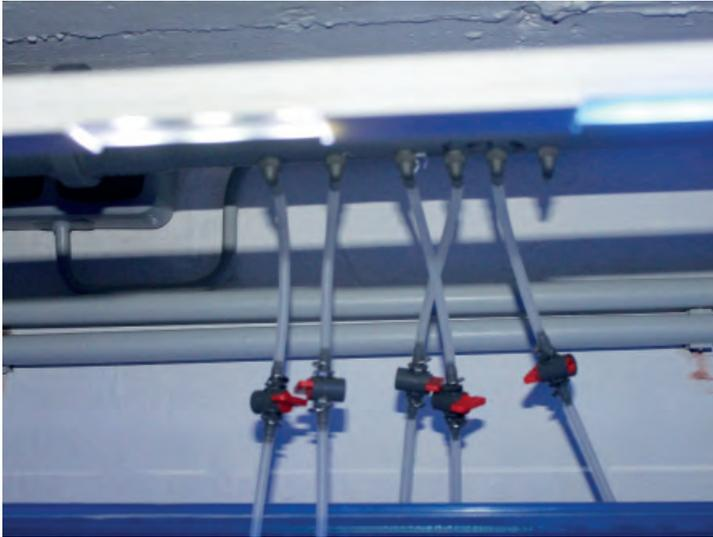
Zur Regulierung der Luftmengen an den Lufthebern werden Absperrventile des Gardena-Micro-Drip-Systems (4/6 mm) verwendet.
