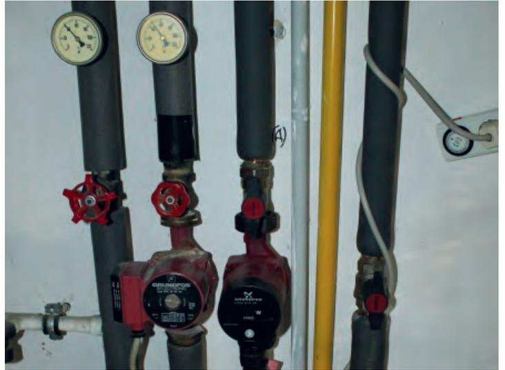
Dazu wurde ein gesonderter Heizkreislauf an der Zentralheizung installiert.
