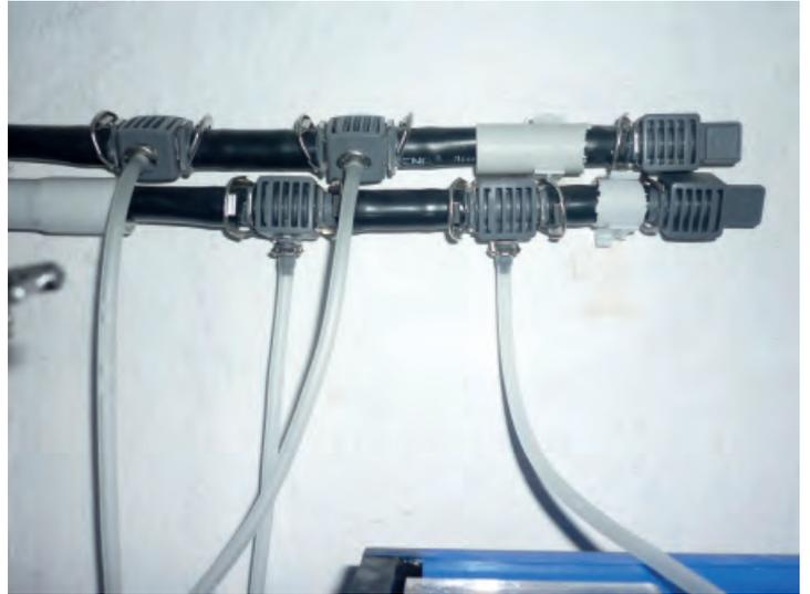
Die Schlauchenden des Systems werden mit passenden Endstopfen verschlossen.
