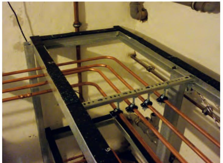
Unter beiden Aquarienreihen wurden ca. 90 Meter Heizschlangen aus 15er CU-Rohr verlegt. Hier eine Detailansicht...
