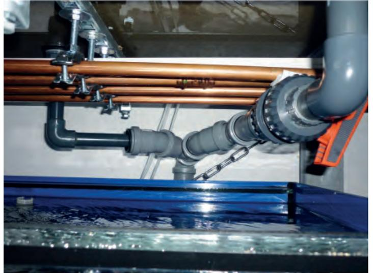
Die Abläufe unter den Aquarien. Hinten links der 25er Überlauf vom automatischen Wasserwechsel. Vorne rechts der Ablauf für den großen Wasserwechsel mit Absperrhahn in 32 mm.
